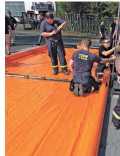
Die Anlage ist modular aufgebaut und kann im Lkw leicht transportiert werden. Die Wanne wird ausgerollt und darüber die Sprüheinrichtung montiert.
