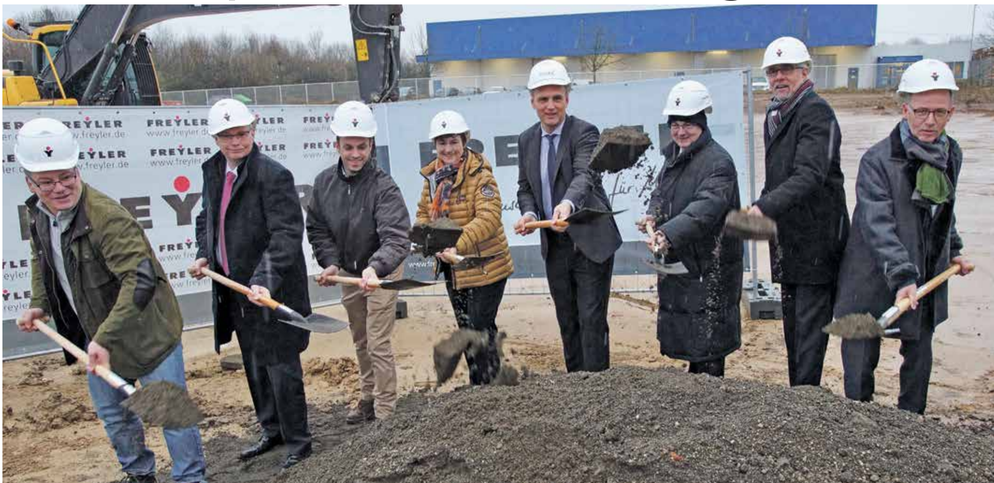
Mit dem Spatenstich fiel der Startschuss für den Neubau einer Logistikhalle mit Büro der Firma Fincke Hygiene Fachgroßhandel in Bassenheim.
