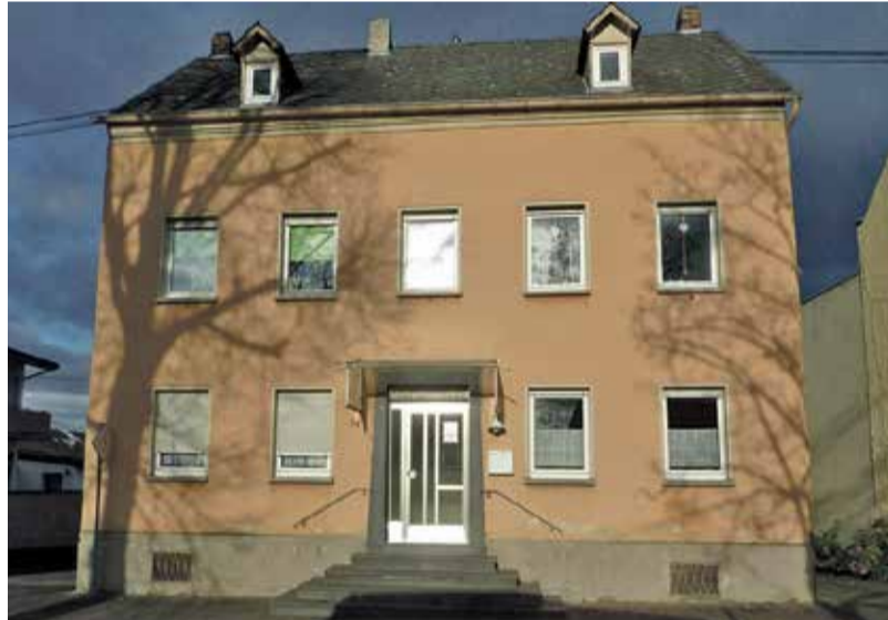
Das ehemalige Pfarrhaus in Lehmen erhielt eine neue Dacheindeckung, die Fenster wurden gegen gegliederte, denkmalgerechte Holzfenster ausgetauscht. Außerdem erfolgten Überarbeitung und Neuanstrich des Gebäudes.
