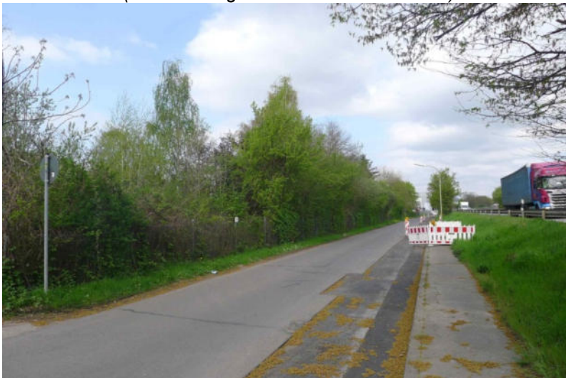
Abbildung 3: Straße `Untere Rheinau`, B 42 und Gehölzstreifen am Rand des Stadtwerke-Areals (Blickrichtung Südosten → Nordwesten)
