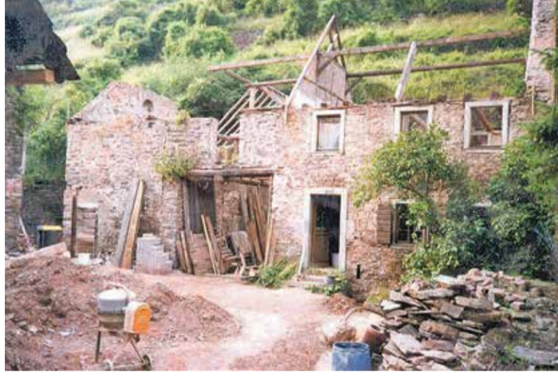
Dieser alte Bauernhof in Gondorf wurde von einem Architektenpaar umgebaut.
