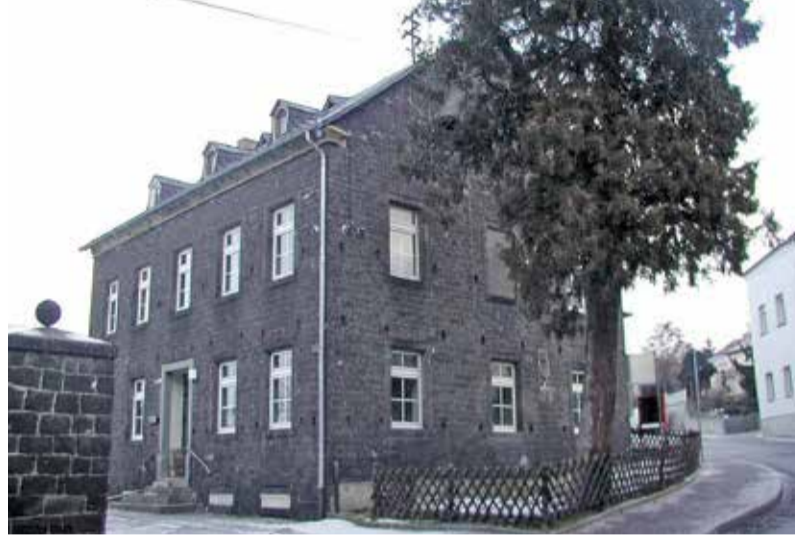
Ein Steinrestaurator hat dieses alte Haus in Thür modernisiert.
