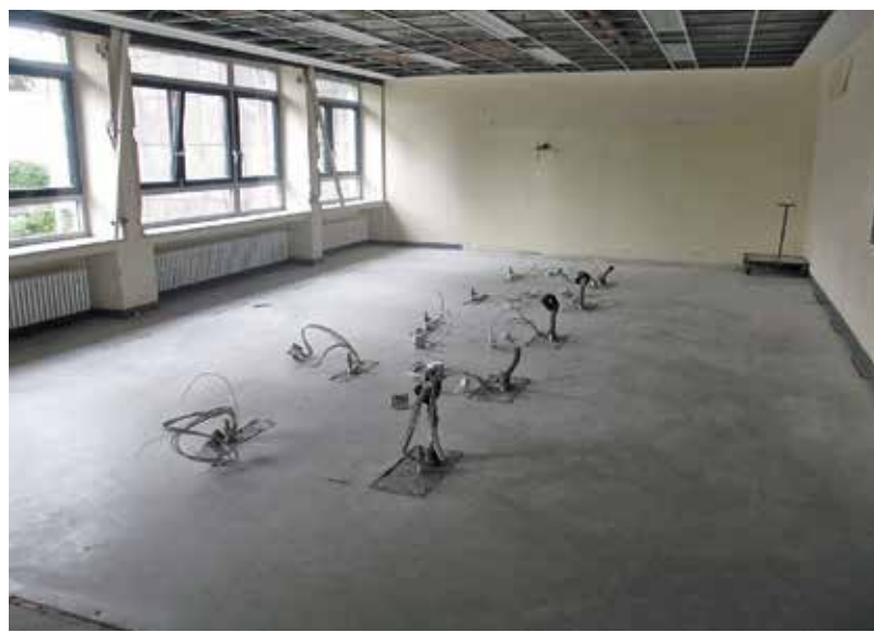
Am Wilhelm-Remy-Gymnasium in Bendorf werden die naturwissenschaftlichen Räume saniert und Versorgungsanschlüsse installiert.
