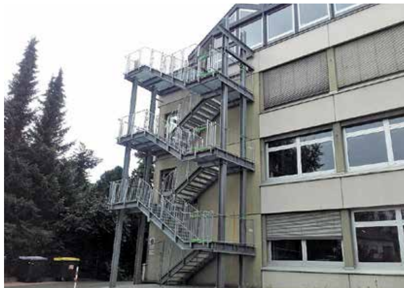
An der Carl-Burger-Berufsbildenden Schulen in Mayen wird der Brandschutz in den Fluren verbessert. Ein Aufzug für die Barrierefreiheit und eine Stahltrappe als zweiter Fluchtweg wurden bereits im vergangenen Jahr errichtet.
