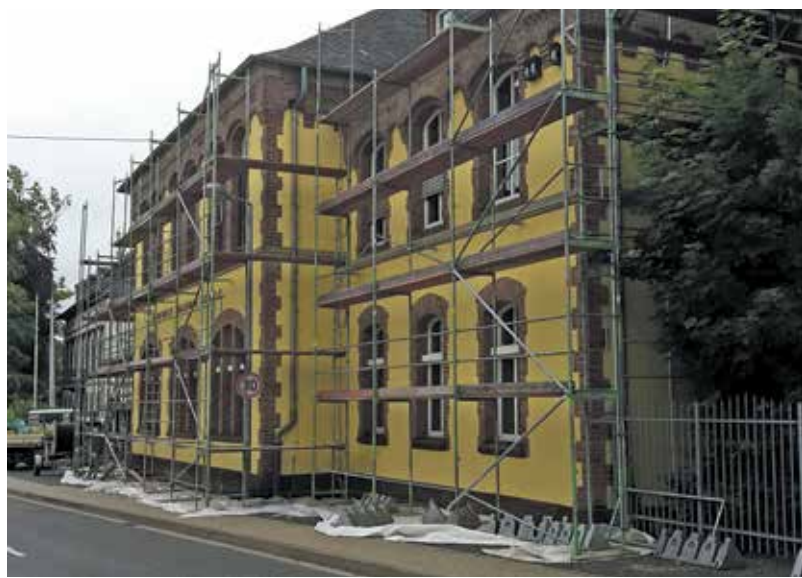
Gerüstbau für die Sanierung der Dacheindeckung des denkmalgeschützten Teils des Kurfürst-Balduin-Gymnasiums Münstermaifeld.
