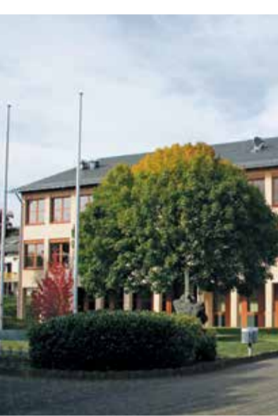
Wenn der Umbau an der IGS Maifeld in Polch abgeschlossen ist, werden 1.000 Quadratmeter neue Fläche zur Verfügung stehen.
